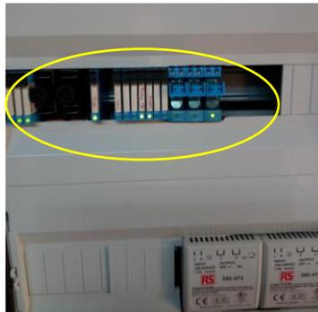
Figura 3.5. Imagen de la caja de la electrónica donde se encuentran los relés (círculo amarillo) que permiten al sistema actuar bajo una orden. La caja está situada en el laboratorio del MPL-3 en SCO.
